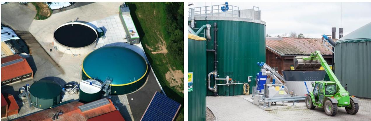
Abbildung 4-4: Luftbild: Großtechnische Versuchsbiogasanlage am Landwirtschaftszentrum in Bad Hersfeld (links), Versuchsfermenter (rechts) (Bildquelle: Fraunhofer IEE)
