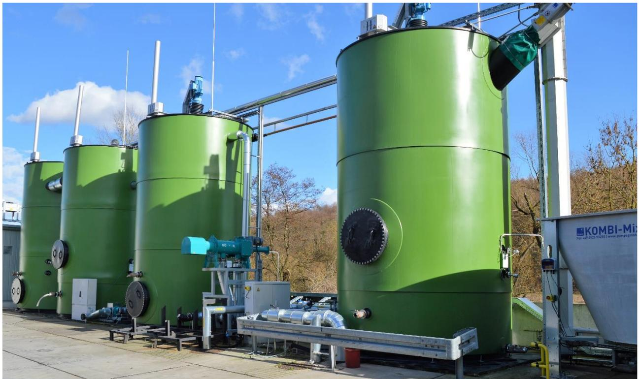
Abbildung 4-7: Großtechnische ReBi-Demonstrationsbiogasanlage am Landwirtschaftszentrum in Bad Hersfeld (Bildquelle: Schünemeyer, Fraunhofer IEE)
