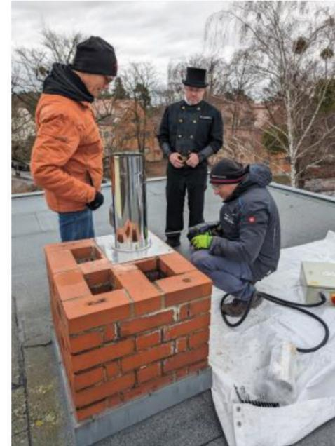
Die ersten Partikelabscheider sind inzwischen installiert. Dabei müssen die Vorgaben des Denkmalschutzamtes beachtet werden. Vorgesehen ist, dass unterschiedliche Partikelabscheider im Wohnraum, im Dachgeschoß und auf dem Dach installiert werden.
