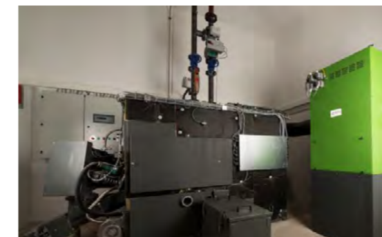
Abbildung 1: 240 kW- Hackgutkessel mit Elektroabscheider
