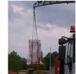
Einbringung Filter durch Deckenöffnung
