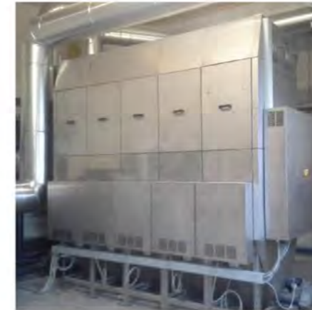
Wien AT: Doppelanlage Herz 1'000 + 300 kW Brennstoff Hackschnitzel W30 OekoRona 5M + 2M
