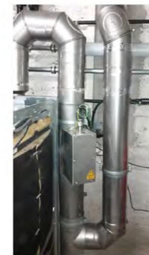
Pelletkessel 24 kW
