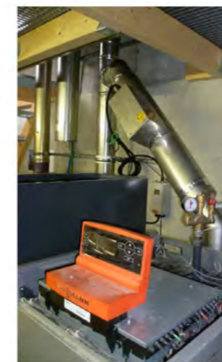
Pelletkessel 18 kW
