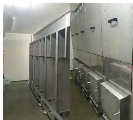
Schaan FL: Mawera 850 kW Hackschnitzel W35 OekoRona 5M – niedere Bauform Montage in Einzelteilen
