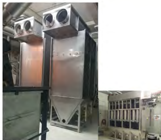
Erlinsbach AG: Doppelanlage Schmid 360 + 550 kW Brennstoff Hackschnitzel W45 OekoRona 2M + 4M
