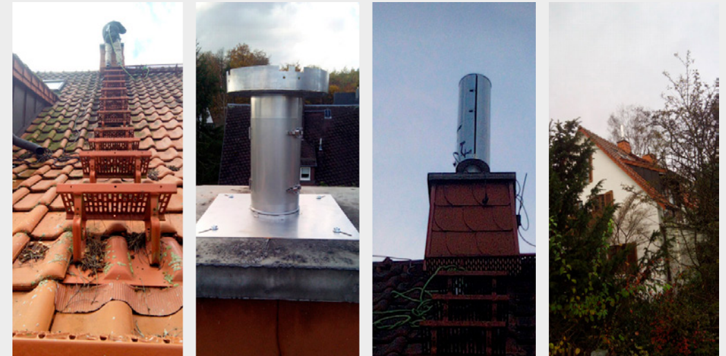
Abb. 25: ESP-Installation an einem Feldstandort
