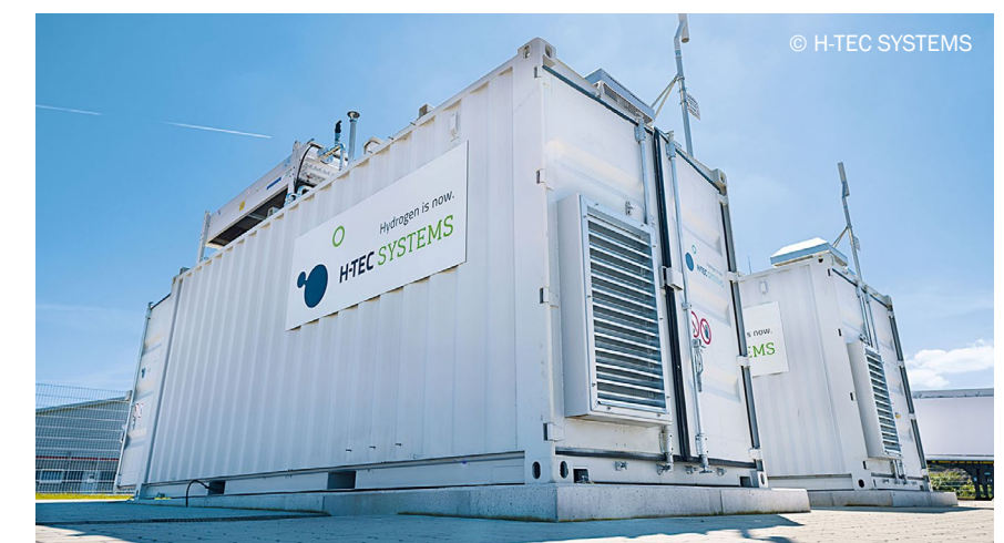
Abbildung 4: Zwei Quest One Elektrolyseure im Einsatz (Quest One 2025)
