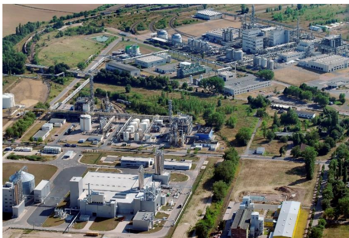
Chemie- und Industriepark Zeitz / Foto: © Infra-Zeitz Servicegesellschaft mbH
