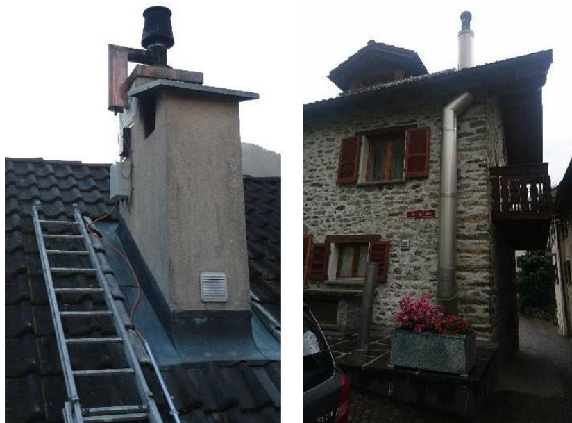
Installierte Feinstaubabscheider bei zwei untersuchten Anlagen. Bilder: © Verenum AG
