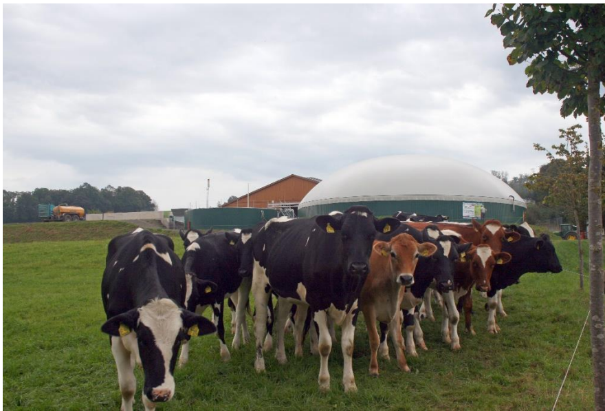
Welche Nutzungsoptionen und Handlungsempfehlungen sind für den Erhalt und den Ausbau der Gülleenutzung in Biogasanlagen möglich? Foto: NQ-Anlagentechnik GmbH, Roland Hitzenbichler
