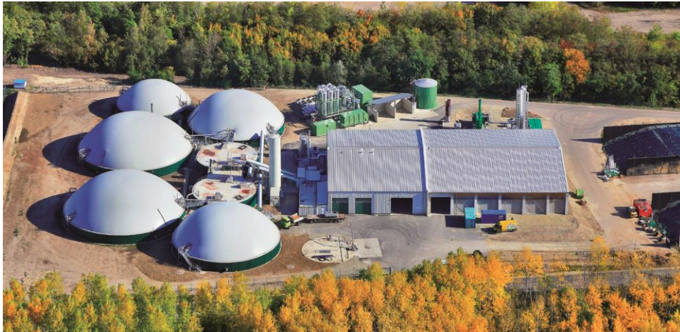
Abbildung 1: Biogasanlage Röblingen am See © UTS
