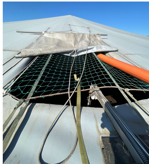
Gasentnahmestelle und Positionierung der Temperatursensoren + Füllstandssensor
