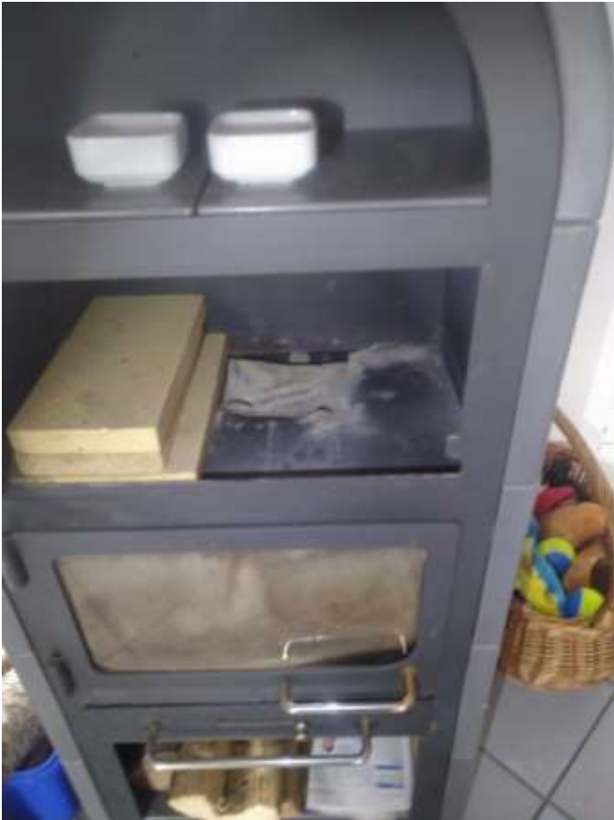
Defektes Umlenkblech
