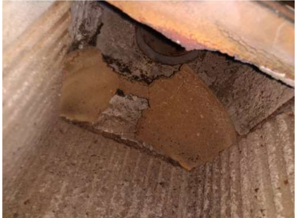
Durchgebrannte Brennraumumlenkplatte → dringend austauschen!
