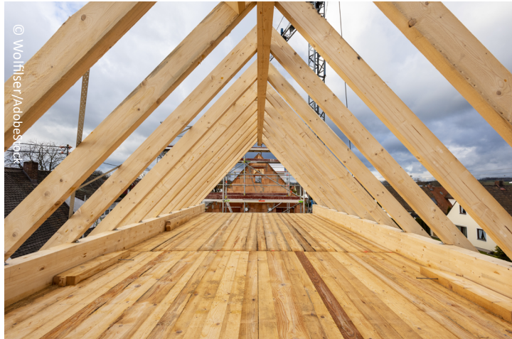
Ein Dachstuhl für ein Einfamilienhaus.
