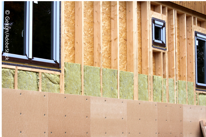
Gebäudedämmung bei einem Holzhaus.
