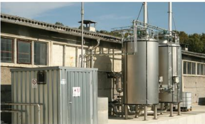
图 75：弗劳恩霍夫陶瓷技术和系统研究所的中试沼气发酵设备
