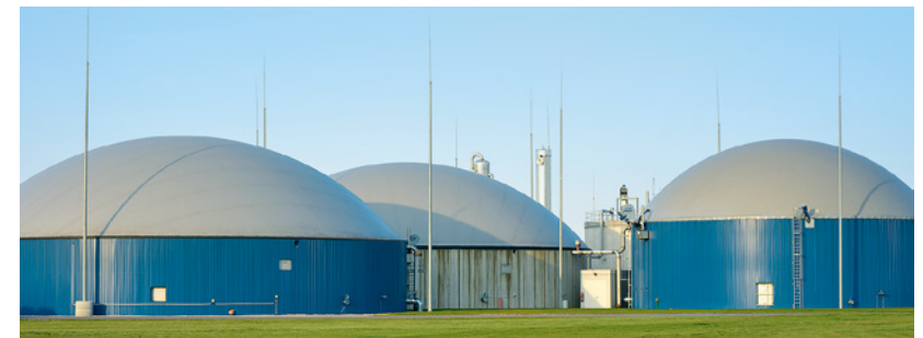
Abb. 2 Biogasanlage der Naturgas Quesitz GmbH bei Leipzig
