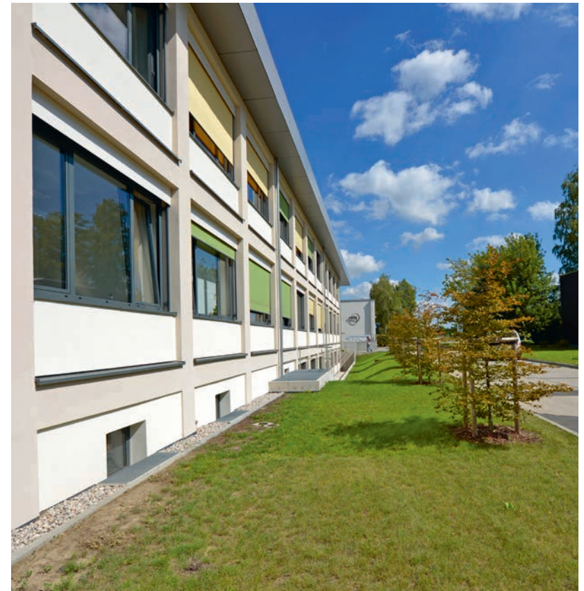
Abb. 40 Das Hauptgebäude des DBFZ in der Torgauer Straße 116
