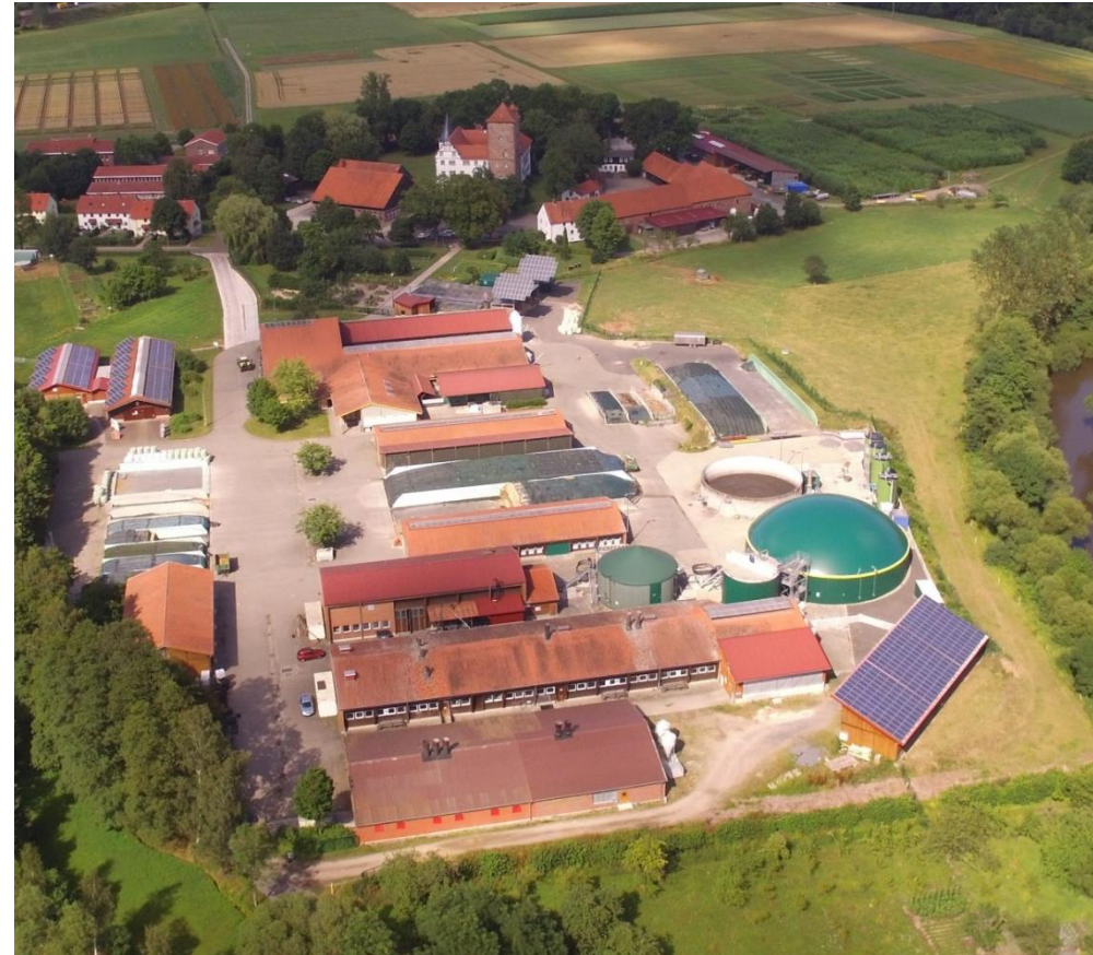
Hessisches Biogasforschungszentrum HBFZ, Bad Hersfeld
